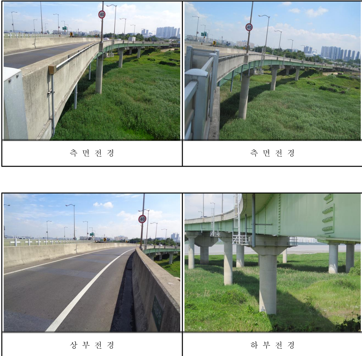
【이산포IC RAMP-G교 전경】
